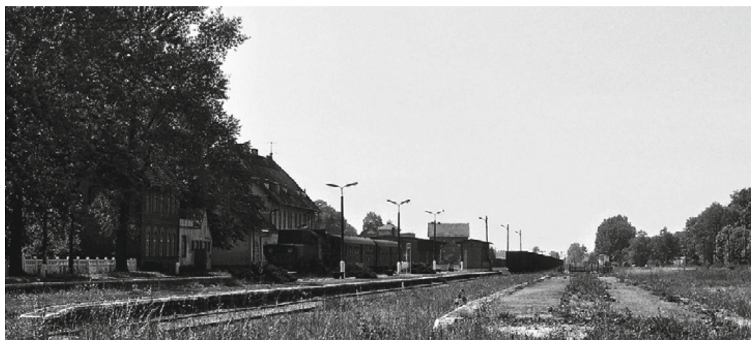
Bahnhof Angerburg in den 1970er Jahren (Foto: Gerhard Greß +)
