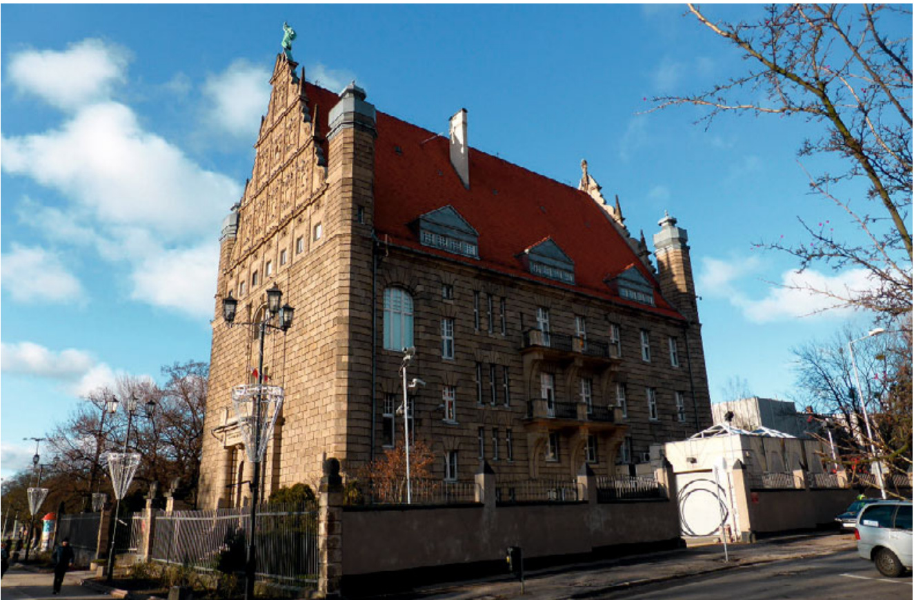
In diesem Gebäude befand sich früher die Thorner Nebenstelle der Deutschen Reichsbank
